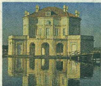
FUSARO La raffinata Casina vanvitelliana del Fusaro, edificio circondato dall'acqua
